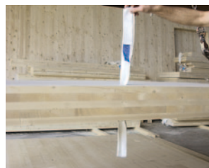
1. Insérer la sangle et la broche dans le perçage
